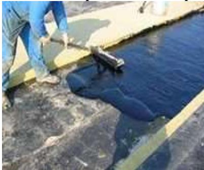
**Мастичные кровельные материалы** представляют собой жидковязкую однородную массу, которая после нанесения на поверхность и твердения превращается в водонепроницаемое покрытие. По составу мастики делят на битумные, битумно-полимерные и полимерные.
