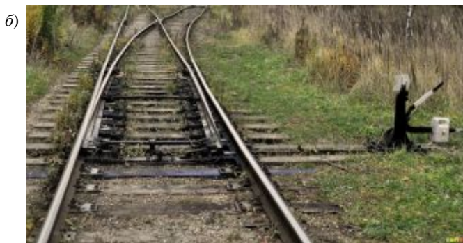
Рисунок 1.1 – Маршрут передвижения через стрелочный перевод: а – по прямому пути; б – на боковой путь
