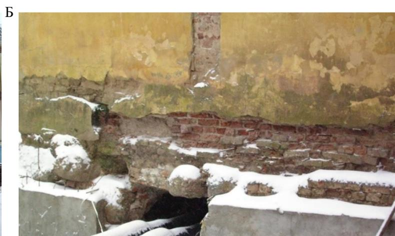
Рисунок 41 – Фотофиксация на разных этапах: А – цвет и состояние фасадов зданий в начале работ; Б – участок зондирования (на оси кадра), наслоения краски, состояние строительных материалов и конструктивных элементов (видны армированные бетонные стенки для укрепления фундамента и отверстие для прокладки труб)
