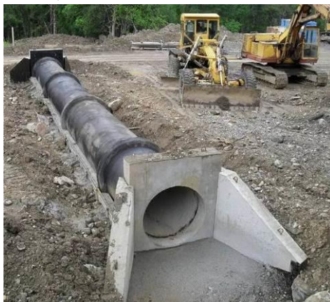
Рисунок 3.6 – Устройство гидроизоляции водопропускной трубы
