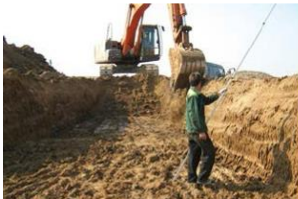
Рисунок 3.2 – Общий вид дна котлована при разработке грунта экскаватором
