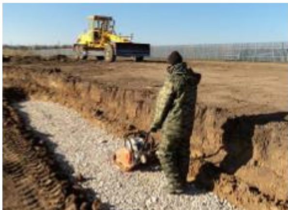
Рисунок 3.3 – Уплотнение щебеночной подготовки вибрационной плитой
