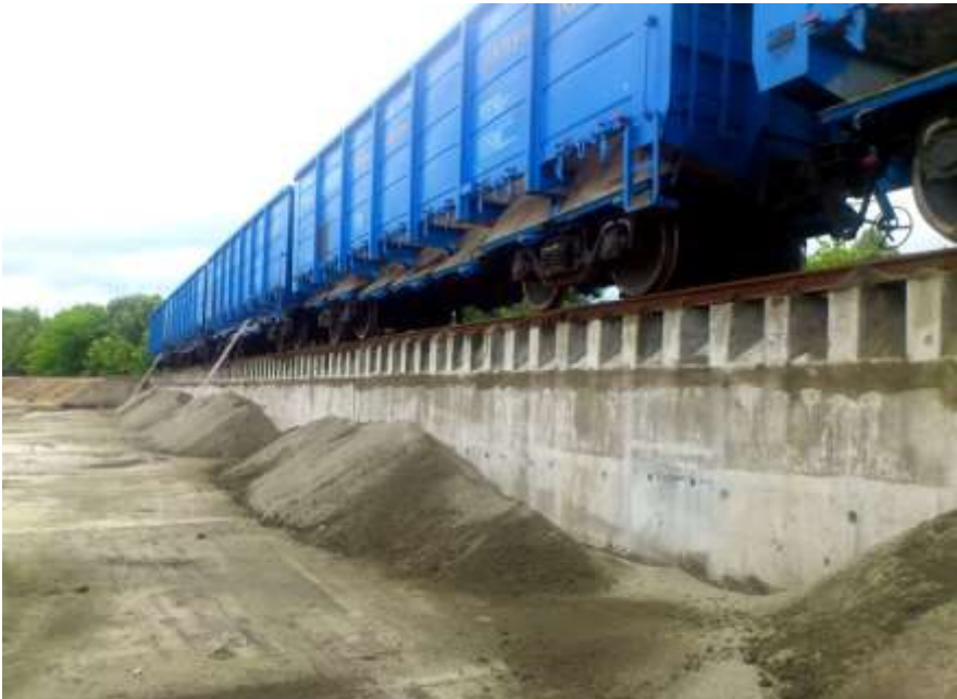
Рисунок 5.3 – Повышенный путь для выгрузки сыпучих инертных грузов
