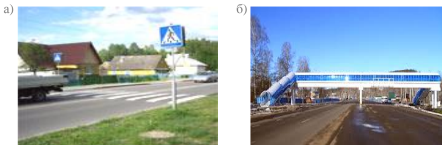
Рисунок 5.17 – Наземные пешеходные переходы: а – обозначенный знаком и дорожной разметкой; б – в виде пешеходных мостов
