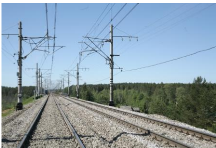
Рисунок 5.38 – Контактная сеть
