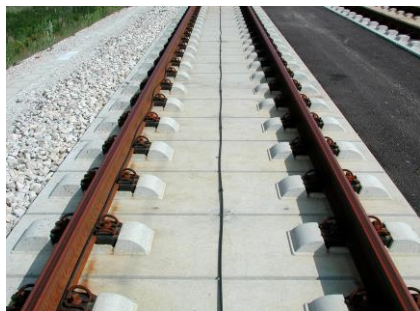
Рисунок 5.32 – Рельсы, уложенные на плиты
