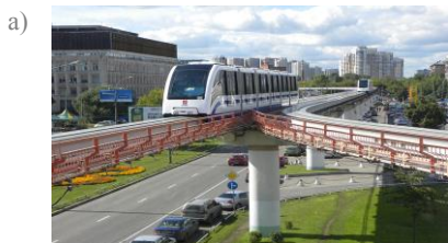
Рисунок 4.85 – Типы навесных монорельсовых дорог: а – с использованием двух рельсов; б – с использованием магнитной подушки
