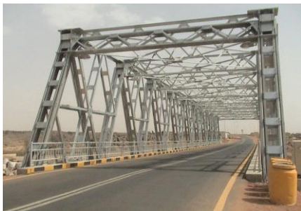
Рисунок 5.9 – Ферменный мост
