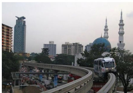
Рисунок 5.64 – Дорожное полотно монорельсовой дороги: а – с ездой понизу; б – с ездой поверху
