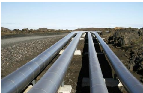
Рисунок 5.72 – Наземная прокладка нефтепровода
