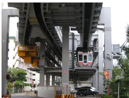
Рисунок 5.64 – Дорожное полотно монорельсовой дороги: а – с ездой понизу; б – с ездой поверху
