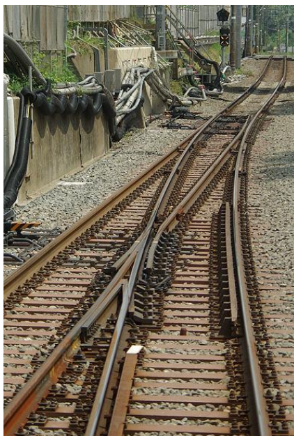
Рисунок 5.35 – Стрелочный перевод с подвижным сердечником
