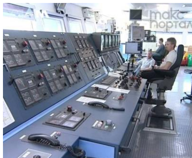
Рисунок 5.70 – Пункт управления газораспределительной станцией
