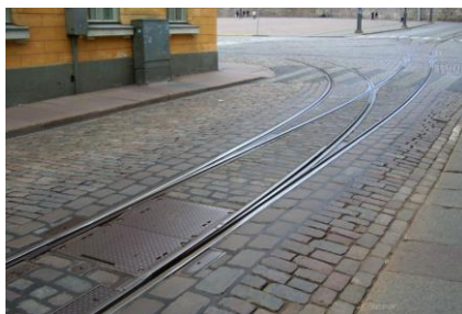
Рисунок 5.62 – Стрелки на трамвайных путях
