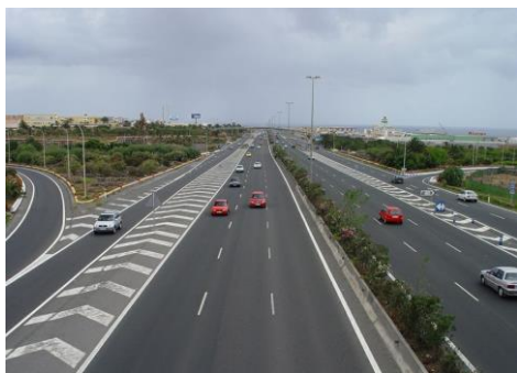
Рисунок 5.2 – Внешний вид скоростной автомобильной дороги
