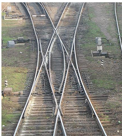
Рисунок 5.34 – Перекрестный стрелочный перевод
