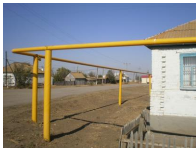
259 Рисунок 5.71 – Газораспределительная сеть
