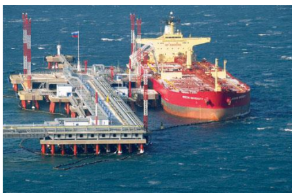
Рисунок 5.75 – Принимающая станция нефтепровода
