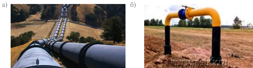
Рисунок 5.68 – Схемы размещения газопроводов: а – на поверхности земли; б – заглубленные
