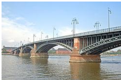
Рисунок 5.6 – Внешний вид металлического балочного моста
