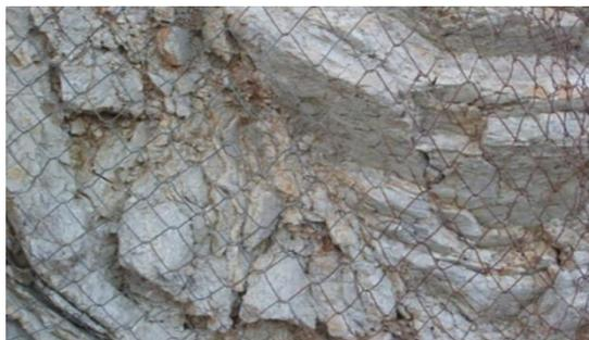
Рисунок 4.13 – Завешивание откосов сеткой из толстой проволоки
