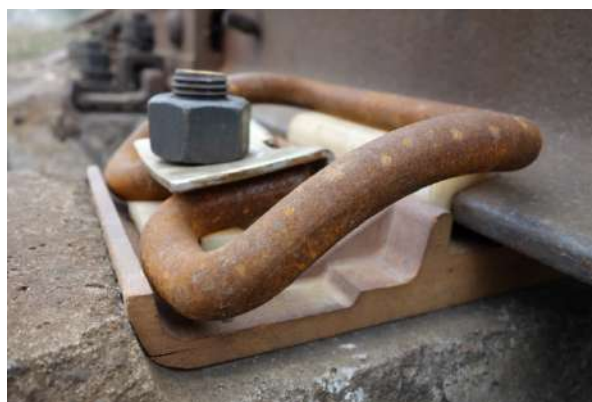
Рисунок 3 – Конструктивная схема скрепления подкладочного нераздельного АЛБТ-65.01:
