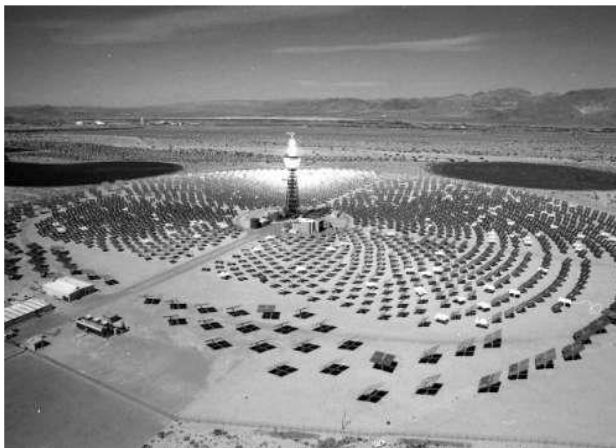
Рис. 25. «Энергобашенный» метод преобразования солнечной энергии в электрическую (в центре «энергобашня» с котлом, вокруг гелиоконцентраторы, постоянно ориентирующиеся на Солнце (Б. Небел, 1993))
