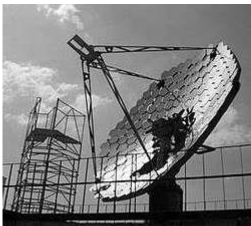
Рис. 24. Параболоидная гелиоустановка с концентратором
