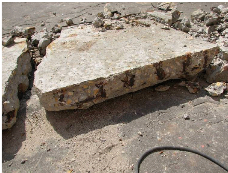
Рисунок 7.38 – Фрагмент балконной плиты: пластинчатая коррозия высокой интенсивности арматурных стержней на участке стыка тела балконной плиты с опорной балкой
