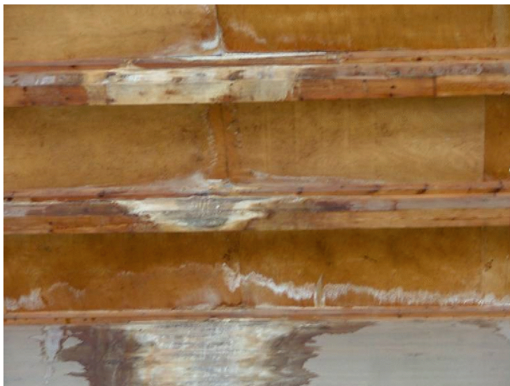
Рисунок 7.14 – Фрагмент подшивки: переувлажнение подшивки и развитие гниения на отдельных участках
