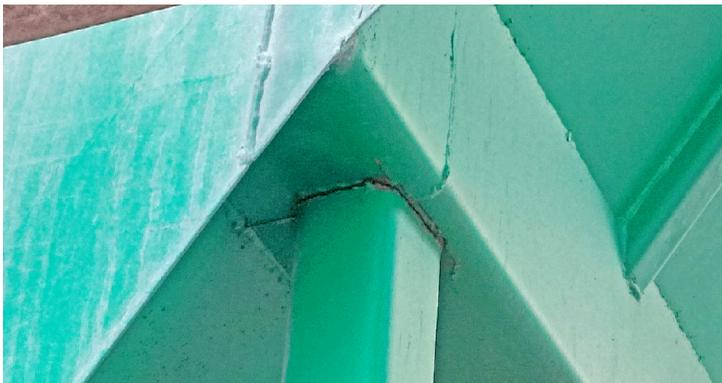
Рисунок 1 – Повреждения узла соединения стойки и основной поперечной балки торцевой стены
