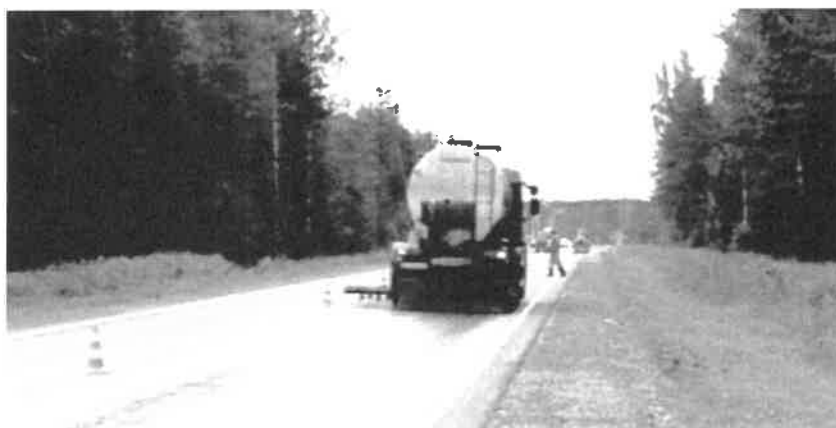
Рисунок 1 – Нанесение ГПС с низкой вязкостью с помощью автогудронатора
