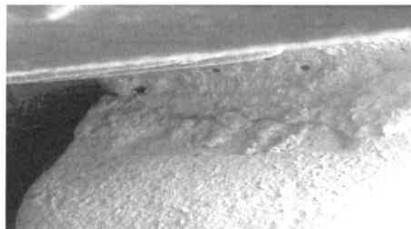
Рисунок 1 – Виды трещин наклонных поверхностей проема фрикционного клина
