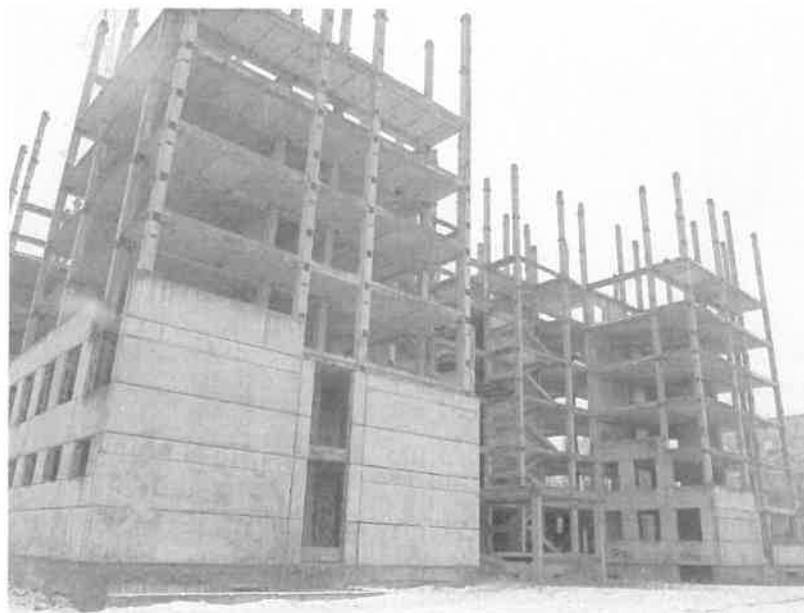
Рисунок 1 – Общий вид обследованного объекта
