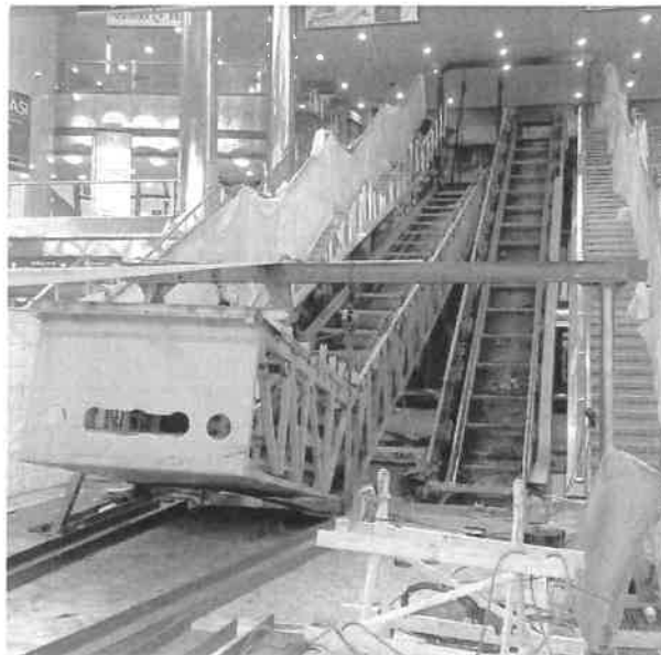
Рисунок 1 – Работы по замене эскалаторов: а – 1-я очередь; б – 3-я очередь
