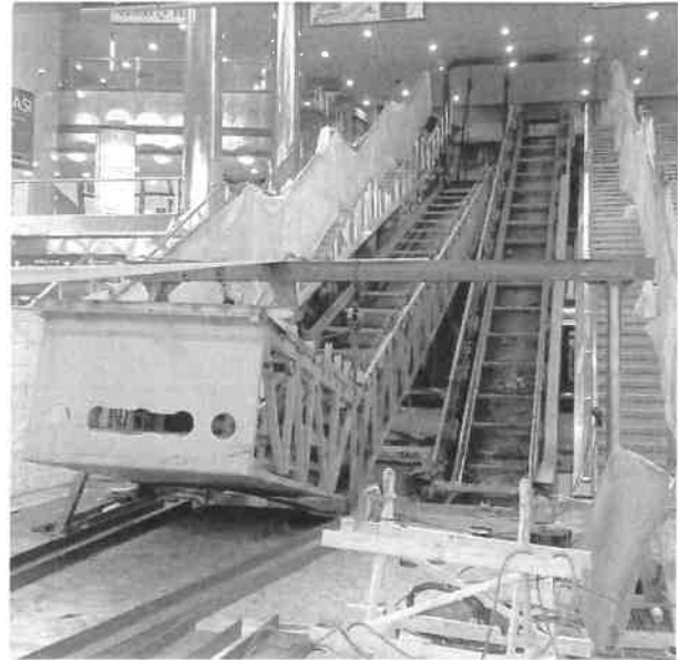
Рисунок 1 – Работы по замене эскалаторов: а – 1-я очередь; б – 3-я очередь
