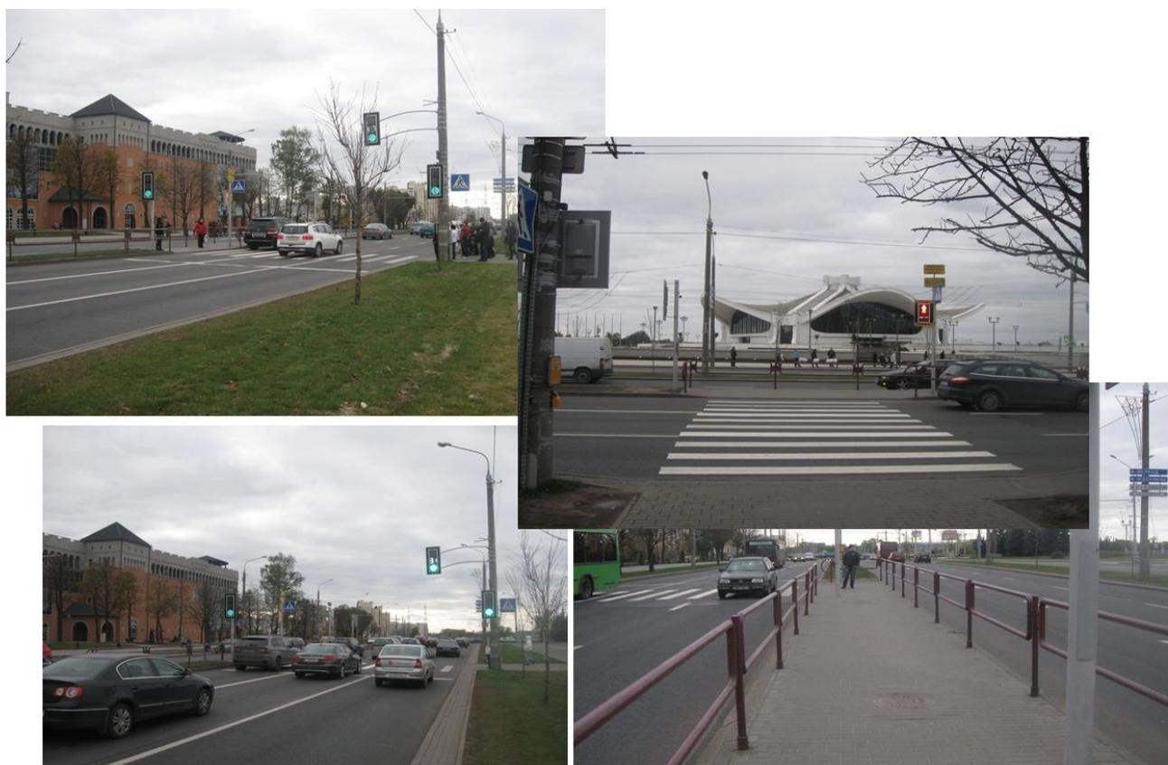
Рисунок 7 – Пример реализации Z-образного пешеходного перехода со светофорным объектом
