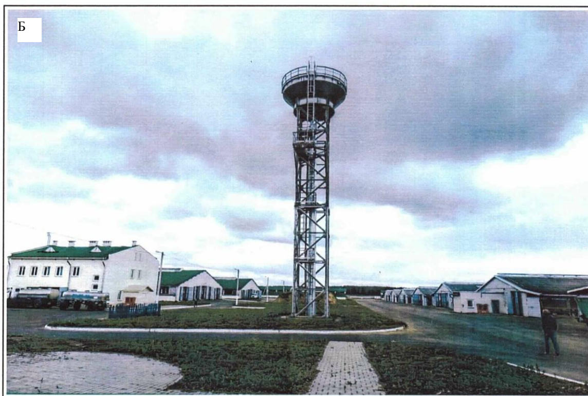
Рисунок 4.10 – Реконструкция животноводческих ферм: А – общий вид рядовой фермы до начала реконструкции; Б – современная молочная ферма на 800 коров в агрогородке Тихиничи Рогачевского района – на переднем плане двухэтажное здание молочного блока и водонапорная башня
