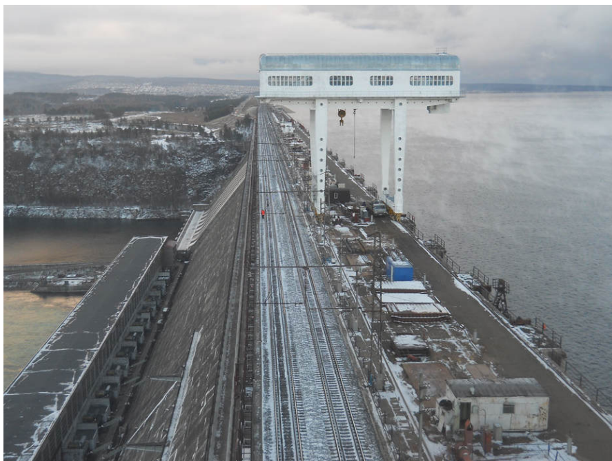
Рисунок 8.3 – Железная дорога проходит по плотине Братской ГЭС
