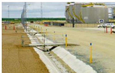
Рисунок 1 – Варианты применения бетонного полотна Concrete Canvas: устройство водоотводной канавы (слева) и укрепление откоса (справа)
