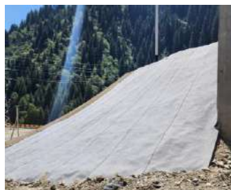
Рисунок 1 – Варианты применения бетонного полотна Concrete Canvas: устройство водоотводной канавы (слева) и укрепление откоса (справа)
