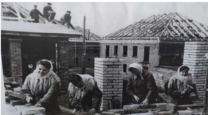
Рисунок 1 – Строительство жилых домов. Минск, 1947 г.
