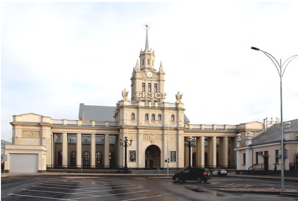
Рисунок 1.7 – Современный вид здания железнодорожного вокзала в Бресте
