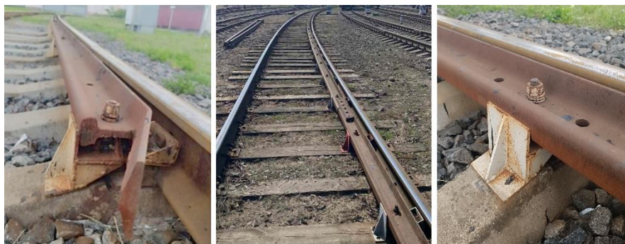
Рисунок 6 – Опытная установка контррельса в кривой радиусом 200 м на подъездных путях в г. Гомеле и станции Могилев -1
