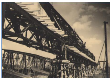
Рисунок 3 – Установка пролетного строения консольным краном на мосту через р. Западный Буг, август 1944 г.
