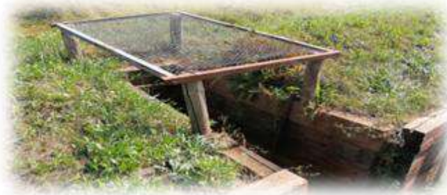
Рисунок 5 – Противодронный козырек для защиты личного состава на позиции отделения
