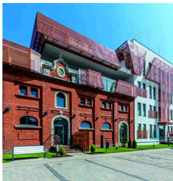
Рисунок 4 – Главный фасад здания
