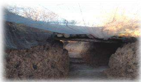
Рисунок 4 – Оборудование хода сообщения противодронной сеткой
