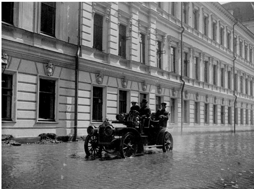
Водосточные трубы уже были, а вот ливневой канализацией еще не занялись
