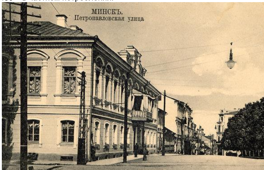
Одна из центральных улиц города – Петропавловская, оборудованная электроосвещением
