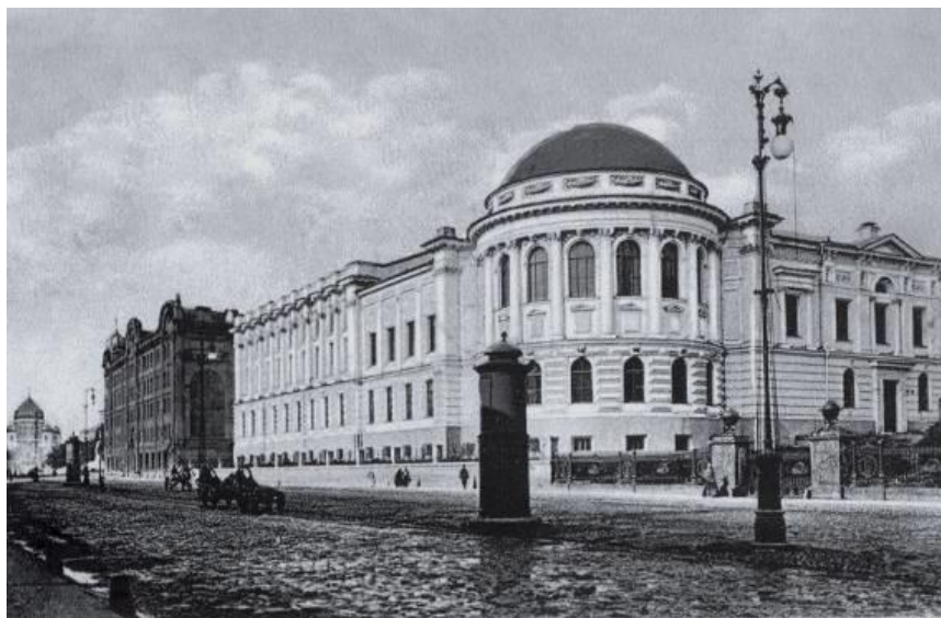
Электрический дуговой фонарь возле здания МГУ
