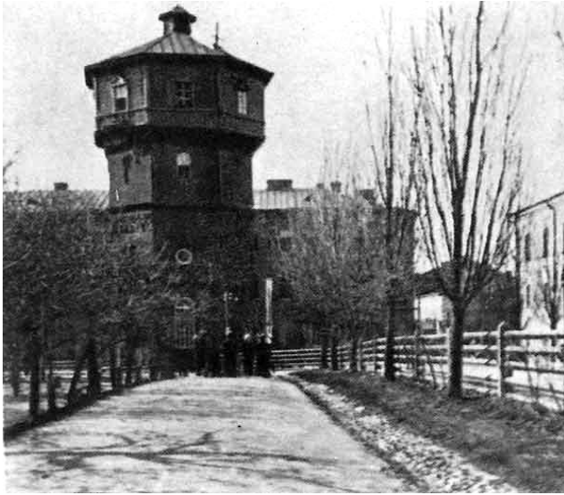
Первая водонапорная башня
