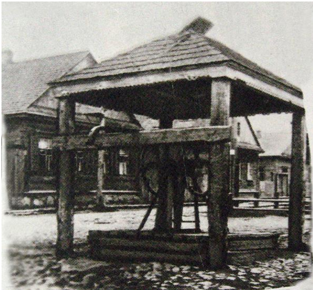
Водокачка, начало XX века
