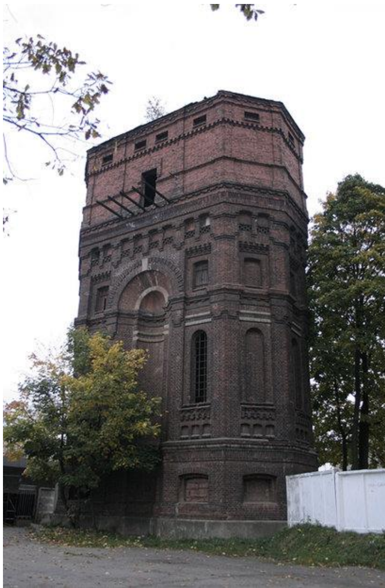
Водонапорная башня на ул. Автодорожной
