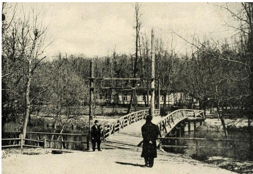
Мост в Городской сад (от места пересечения ул. Полицейской и Подгорной)
