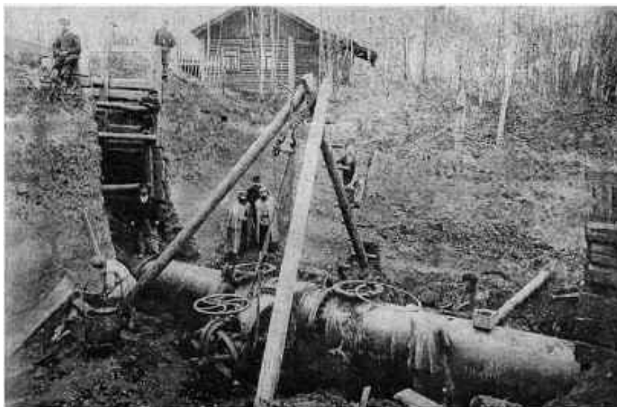
Прокладка водопроводной трубы
