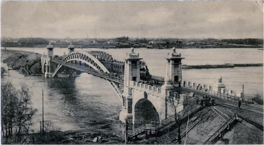
Сергиевский железнодорожный мост
