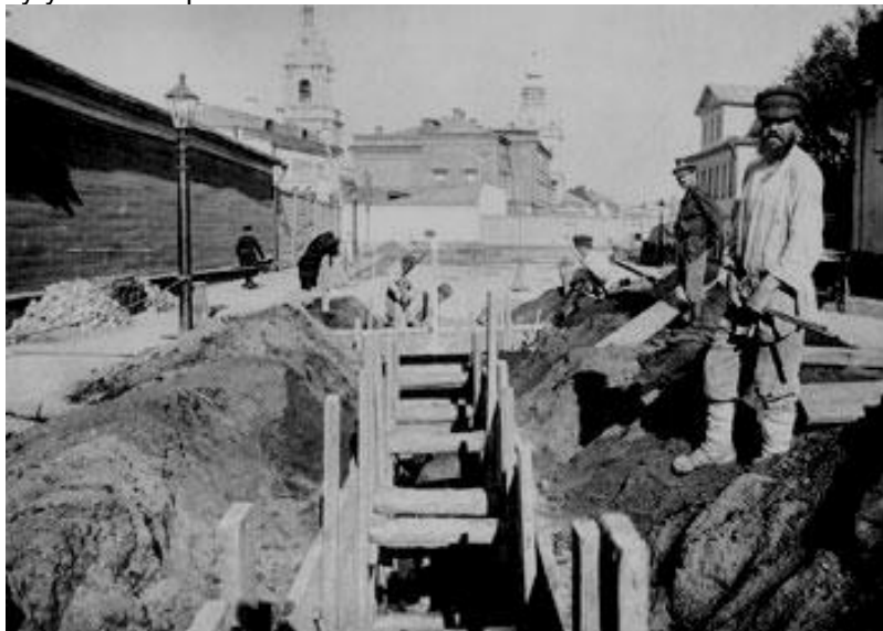
Устройство самотечной ассенизационной канавы. 1890-е годы
