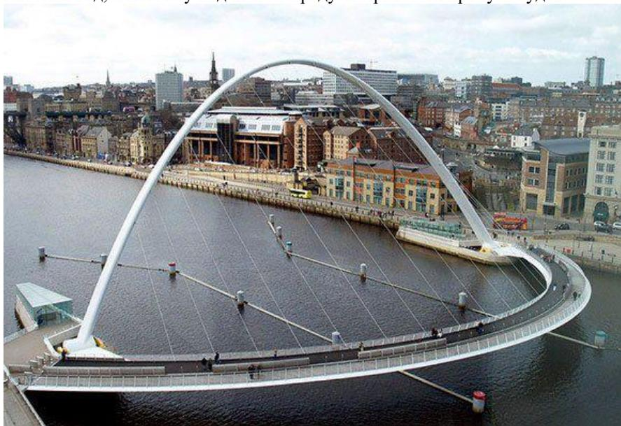
Рисунок 52 – Поворотный мост через реку Тайн (Англия)
