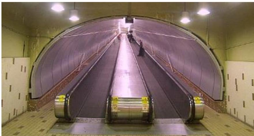
Рисунок 68 – Скоростной пассажирский конвейер в метрополитене
