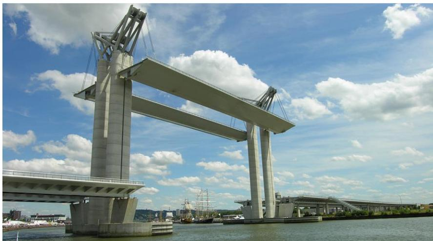
Рисунок 55 – Подъемный автомобильно-пешеходный мост Гюстава Флобера на реке Сесе (Франция)
