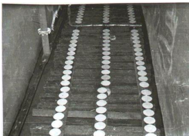
Рисунок 11.22 – Внутренний вид камеры вторичного озонирования предприятия речного водозабора ПО «Минскводоканал» с установленными аэраторами типа ПА-2, 1988 г.
