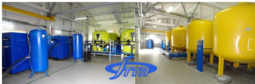
Рисунок 10.2 – Напорные засыпные фильтры для очистки воды, разработанные в НПП по материаловедению НАН Беларуси
