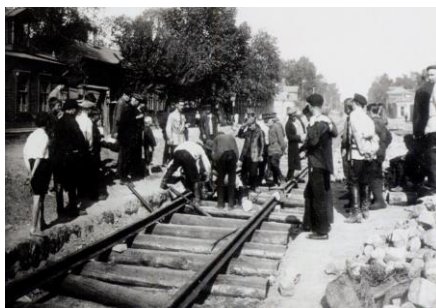
Щербаковская ул. Термитная сварка рельсов. 1925 год
