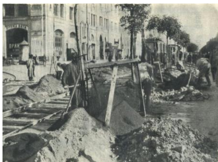
Ремонт трамвайной линии в Китайском проезде. 1924 год
