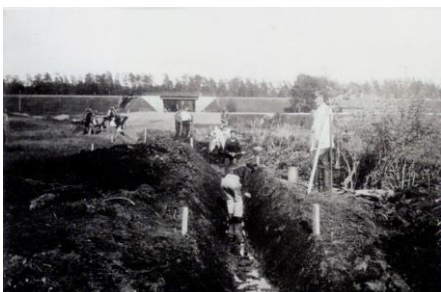
Благуша. Рытье канавы для Измайловской линии трамвая. 1925 год
