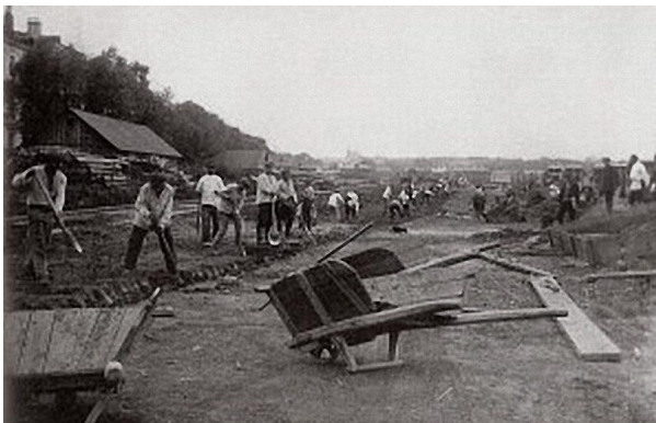
Земляные работы на строительстве Бахметьевского гаража. 1926 год
