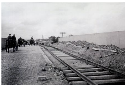
Владимирское шоссе. Укладка рельсов пути Дангаузэровской линии. 1925 год
