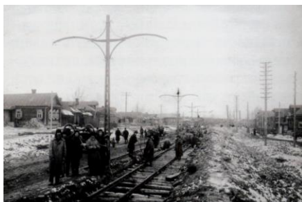
Нижние Котлы. Укладка рельсов Даниловской линии. 1925 год
