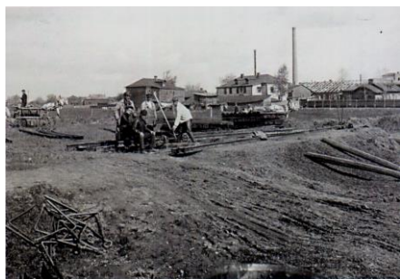
Владимирское шоссе. Монтаж разводного кольца Дангаузэровской линии. 1925 год
