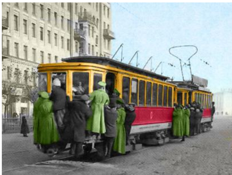
Трамвай типа Ф на Садовом кольце в районе Красных ворот напротив дома Афремова. Октябрь 1917 года
