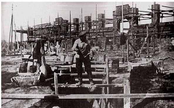
Строительство Бахметьевского гаража. 1926 год
