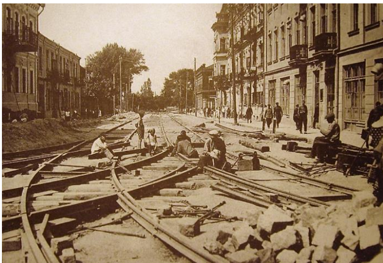
Прокладка трамвайных путей по ул. Володарского. 1933 год
