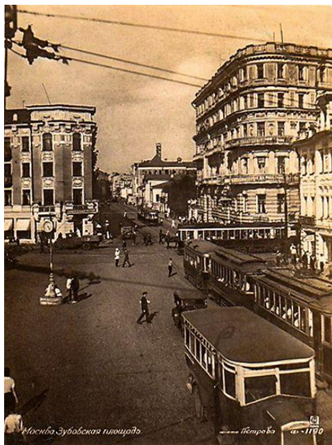
Автобус на Зубовской площади. 1934 год
