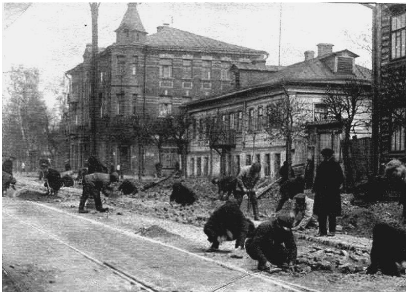
Ремонт трамвайных путей в Сокольниках. 1930–1935 гг.
