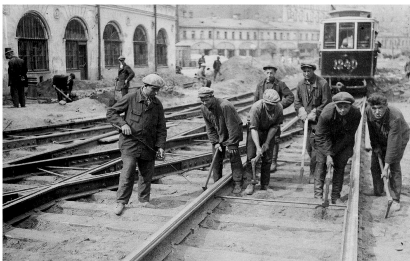
Прокладка трамвайной линии по Манежной улице. 1931 год
