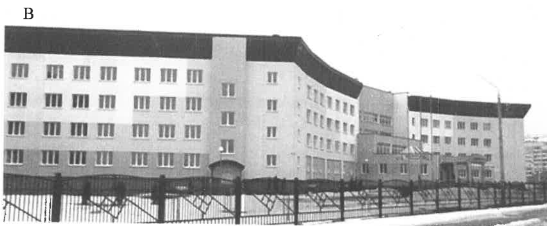
А – проект школы. Компьютерная визуализация: (на рисунке: А – здание школы, Б – бассейн (перспектива)); В – во время строительства; Г – реализация проекта. Фотография вида на главный вход в здание Рисунок 2.4 – Мозырь. Трансформация природных пространств в развернутое объёмно-планировочное решение общественного здания: средняя школа № 16 (архитектор Миргородский А. П.)
