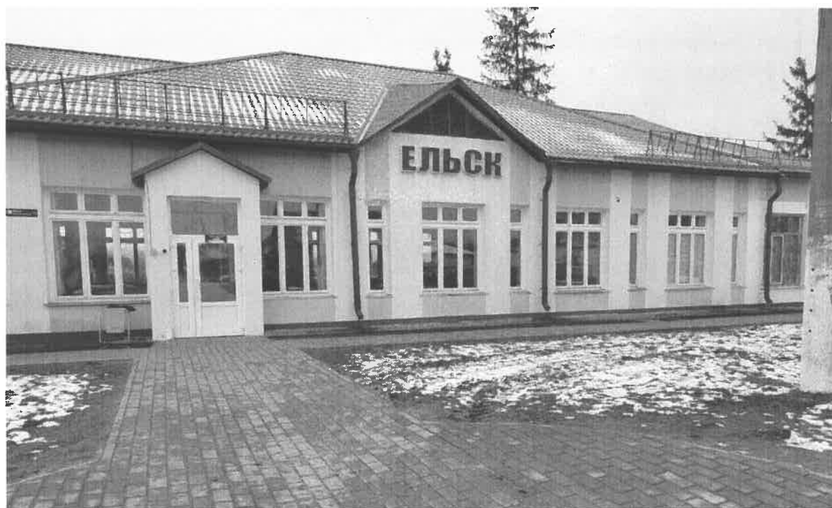
Рисунок 7.54 – Здание железнодорожного вокзала
