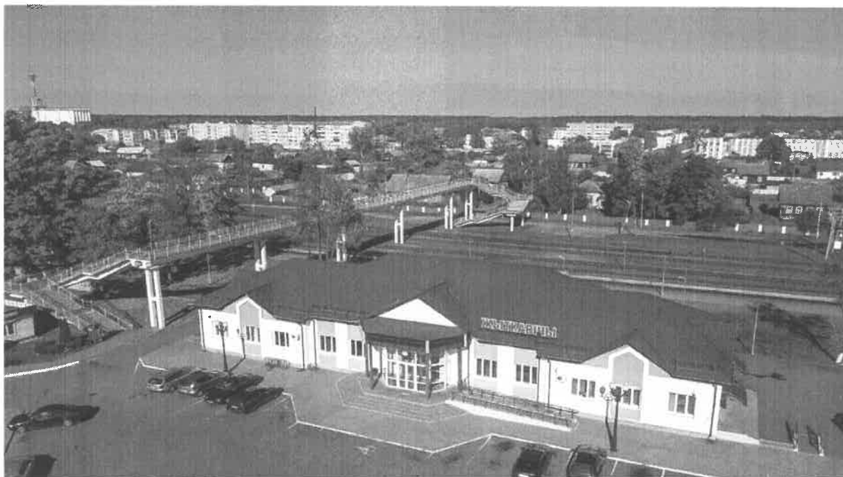
Рисунок 7.34 – Здание железнодорожного вокзала
