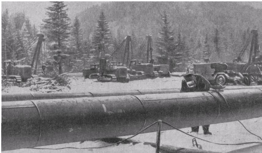
магистраль из сваренных и соответствующим образом изолированных труб с устройствами электрозащиты (рисунок 6.1). Разновидностью линейной части являются наземные и подземные переходы через реки, озера, проливы, болота, автомагистрали, железнодорожные пути и т. д. Для строительства трубопроводов промышленность освоила выпуск труб диаметром 520, 720, 820, 1020, 1220 и 1420 мм;
