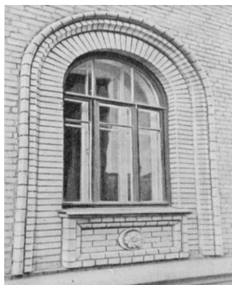
Рисунок 2.5 – Полуциркульный наличник окна первого этажа
