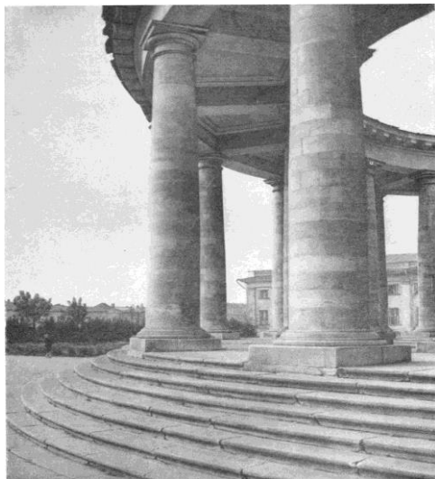
Рисунок 1.18 – Стилобат колоннады в виде полуциркулярной лестницы (ступени из песчаника лекальные с валиком)
