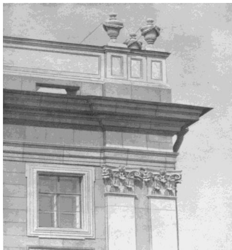
Рисунок 1.36 – Гранитный карниз (архитрав и цоколь парапета из серого гранита; фриз антаблемента и парапет из мрамора; вазы на парапете из известняка. Верхняя плоскость карниза покрыта металлом
