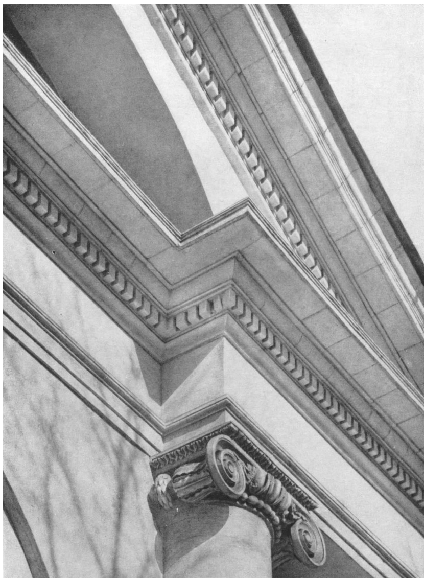
Рисунок 1.38 – Карниз фронтона из известняка (фриз и архитрав выполнены
