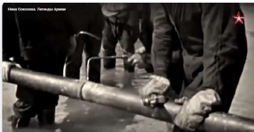
Рисунок 2 – Сооружение топливпровода
