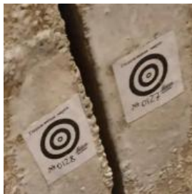
Рисунок 7 – Деформационные марки
