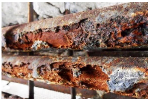
Рисунок 1 – Коррозия
