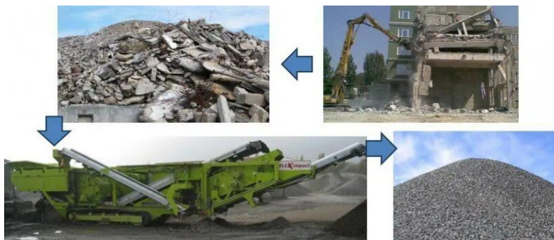
Рисунок 2 – Транспортировка строительного мусора при сносе здания
