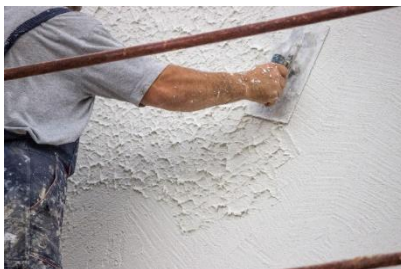
Рисунок 3 – Пример нанесения штукатурки на фасад
