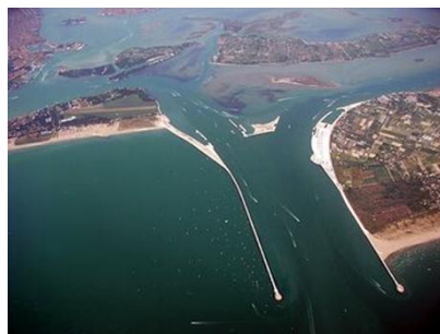
Рисунок 1 – Вид с воздуха на сооружения проекта MOSE
