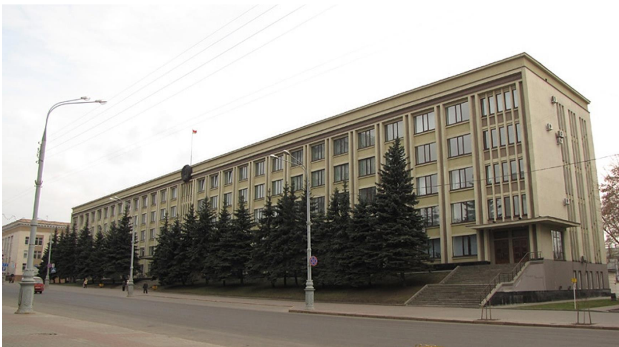
Рисунок 6.4 – Здание Гомельского облисполкома (архит. Певный С. И., Заборский Г. В., инж. Рабкина С. М., Лискович Ф. С.)
