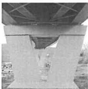
Рисунок 2 – Антикоррозионная защита опор мостовых сооружений лакокрасочными материалами
