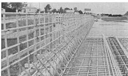
Рисунок 4 – Применение композитной арматуры при строительстве путепровода
