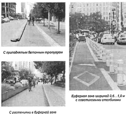
Рисунок 1 – Примеры наиболее удобных (защищённых) вариантов велосипедных полос [1]
