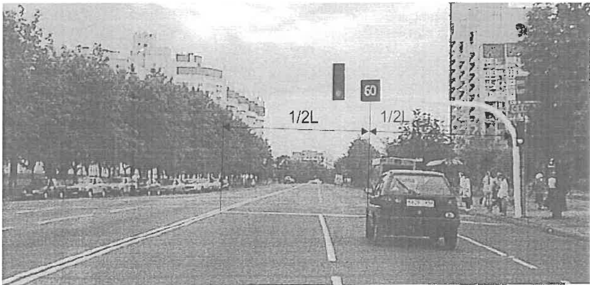
Рисунок 2 – Схема установки УСК на выносной консоли над трехполосной проезжей частью
