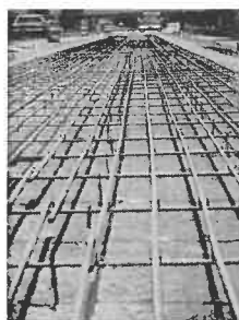
Рисунок 3 – Арматурные каркасы, защищенные полимерными покрытиями
