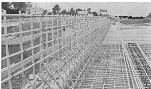
Рисунок 4 – Применение композитной арматуры при строительстве путепровода
