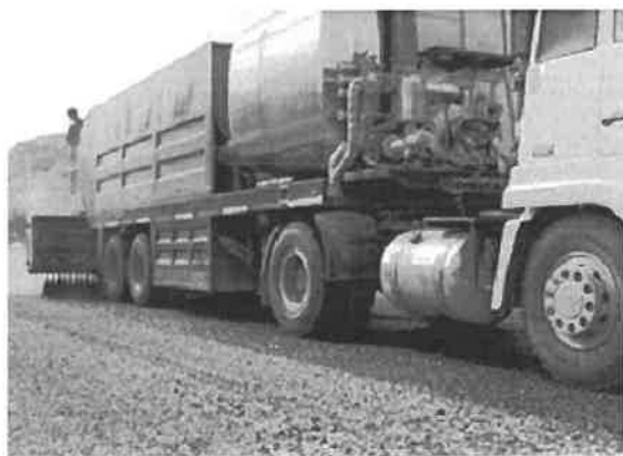
Рисунок 1 – Устройство герметизирующего трещинопрерывающего слоя
