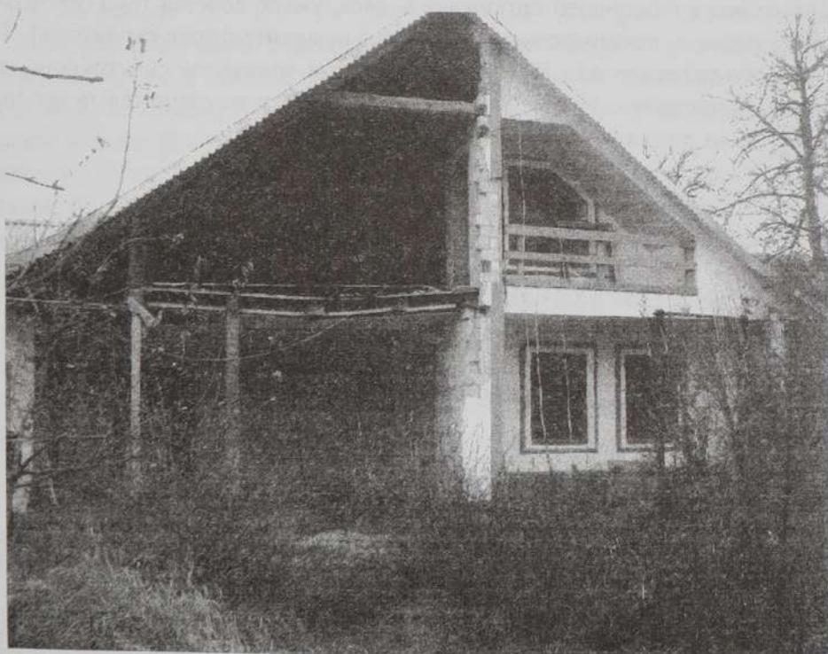
Рисунок 1 – Фрагмент жилого дома после обрушения наружной стены
