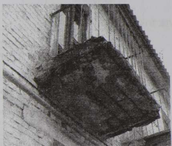
Рисунок 1 – Фрагмент монолитной железобетонной балконной плиты по стальным балкам
