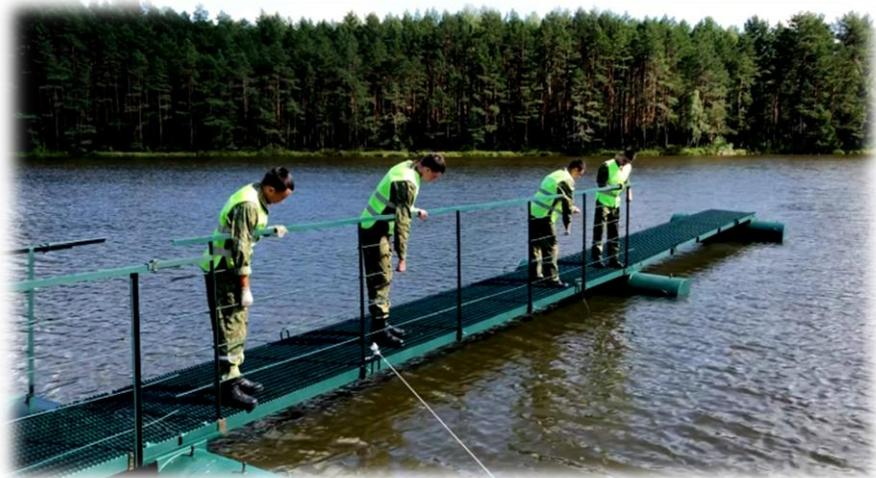
Рисунок 1 – Наплавной сборно-разборный мост
